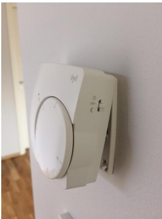
3. Termostaten vil løsne fra braketten. Bytt begge AAA batteriene og fest termostaten på braketten igjen. Pass på at termostaten er dyttet helt på plass.
